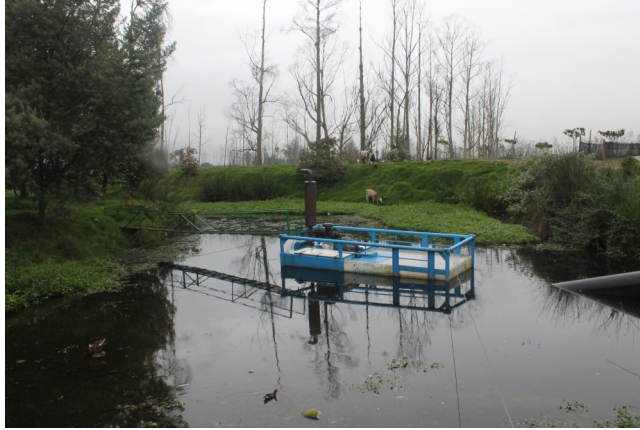
Fotografía Equipo ASIS, Planta de Bombeo Humedal Jaboque _ Localidad Engativá 2015, Archivo Fotográfico UPZ 74 Engativá
