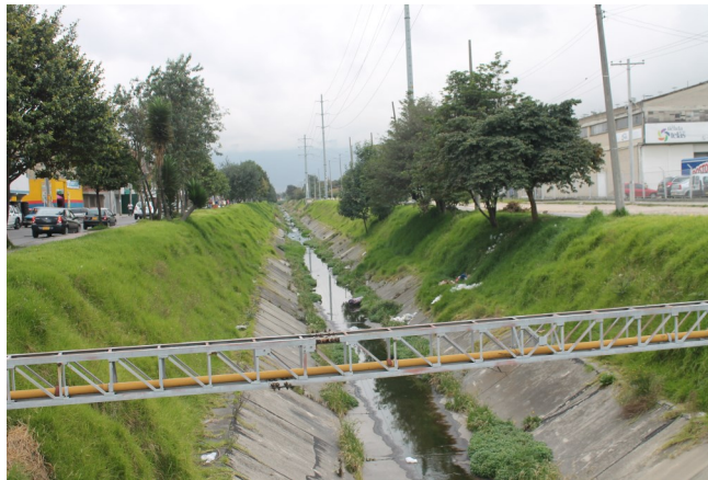
Fotografía Equipo ASIS, Inadecuado manejo de residuos Localidad Engativá 2015, Archivo Fotográfico UPZ 116 Álamos
