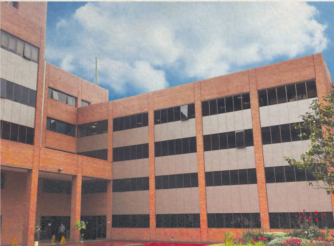
La nueva sede del Laboratorio de Salud Pública ocupa la esquina suroriental del Centro Distrital de Salud.
