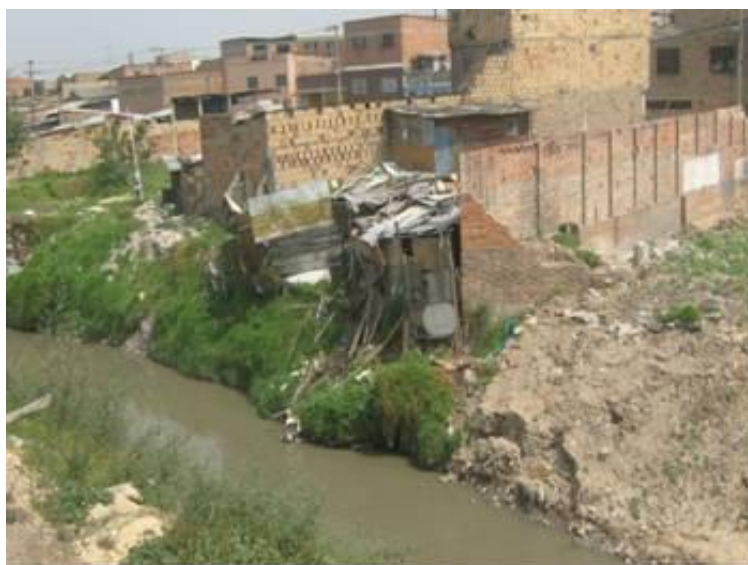
Foto 2 Contaminación Y Deterioro Del Suelo En El Barrio Hoyo – Tunjuelito.
