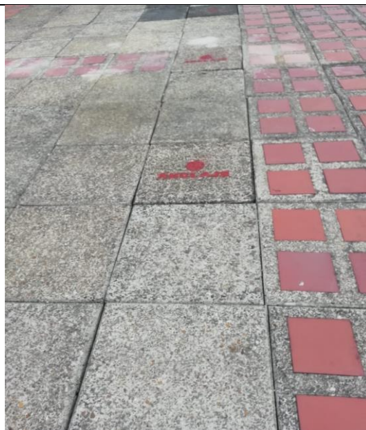
Instalación de anclajes en terraza del edificio del Hemocentro Alto
