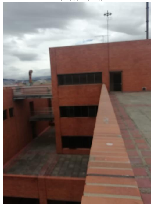
Mantenimiento de Fachada
