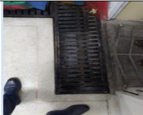
Centro de acopio (canaletas perimetrales, contra derrame de líquidos, lavado)
