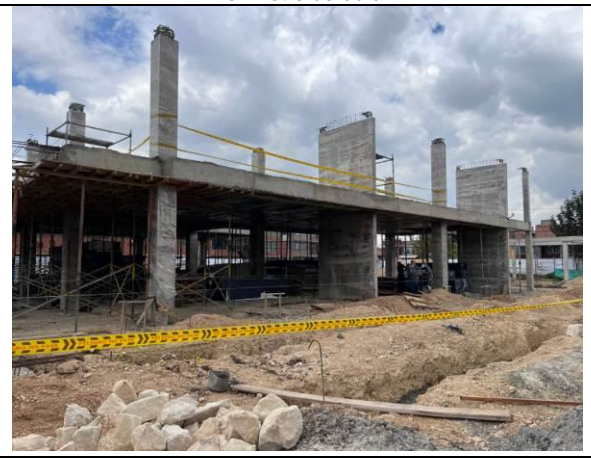
Avance de obra costado oriental
