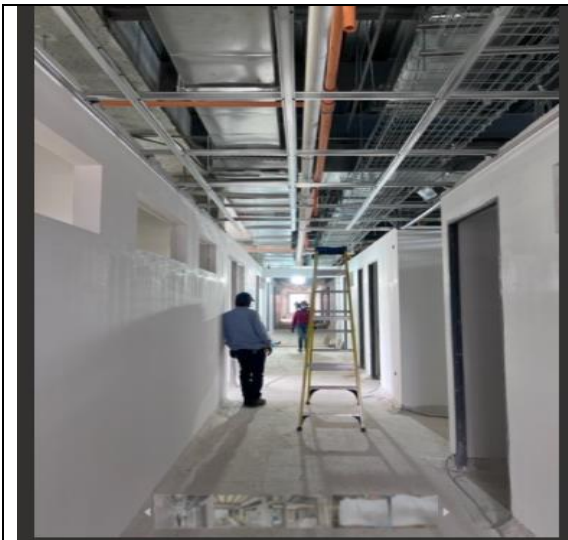
Activiades de obra en primer piso
