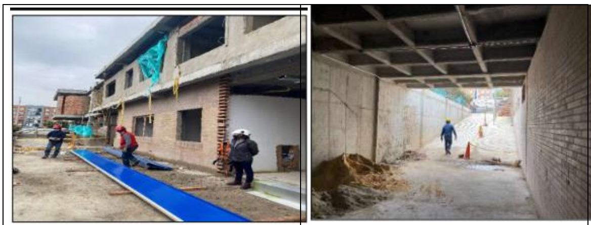
Fuente: Visita a obra 15 de febrero de 2022- Dirección de Infraestructura.
