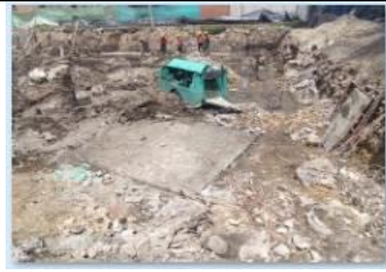
Avance de excavación y descabece de pilotes
