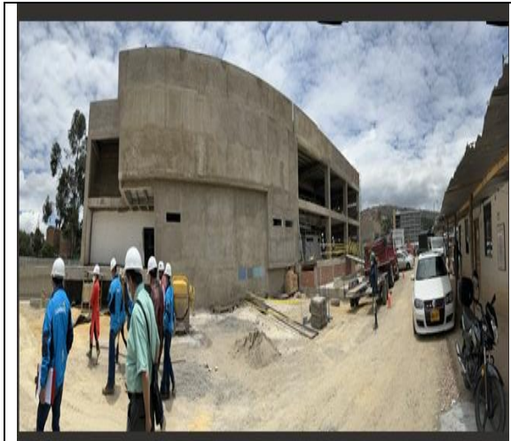
Edificación de obra
