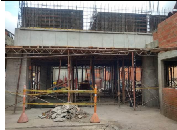
Actividades de obra y tanques de almacenamiento de agua
