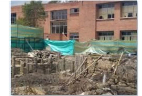
Avance del descabece de pilotes
