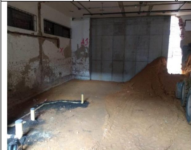
Adecuación de terreno interno
