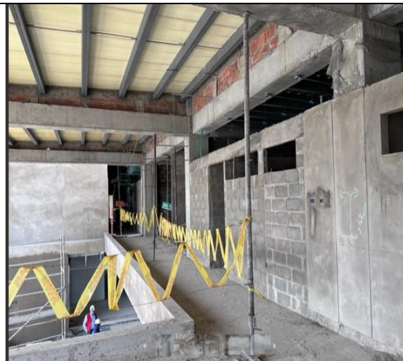
Mamposteria sin terminar en segundo piso
