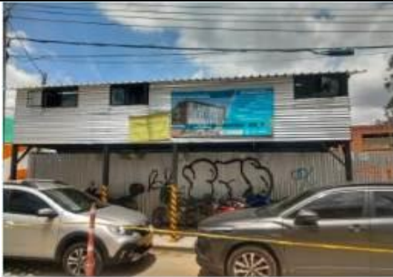
Campamento de obra.
