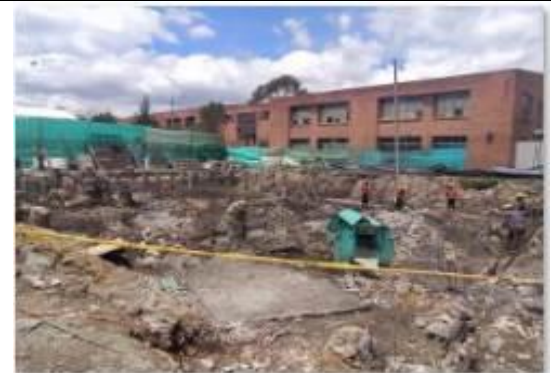
Obra en general.
