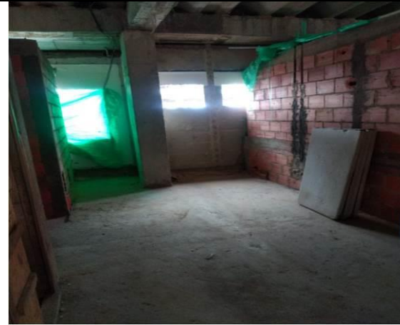
Muros y divisiones de consultorios de atención y mampostería
