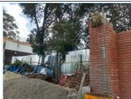
Cerramiento permanente en los alrededores de la obra con predios colindantes.
