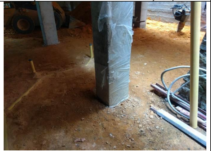
Reforzamiento de vigas y estructuras
