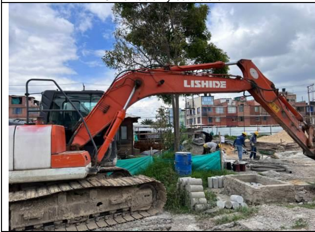
Equipos de obra y materiales
