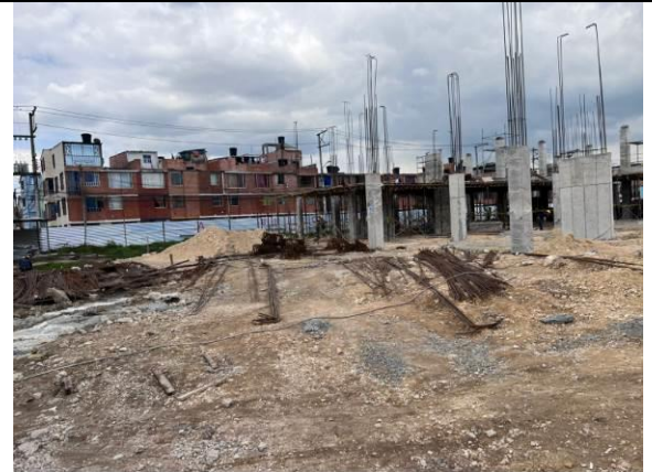
Perímetro de obra
