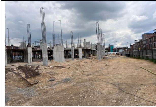
Cimentación y estructura
