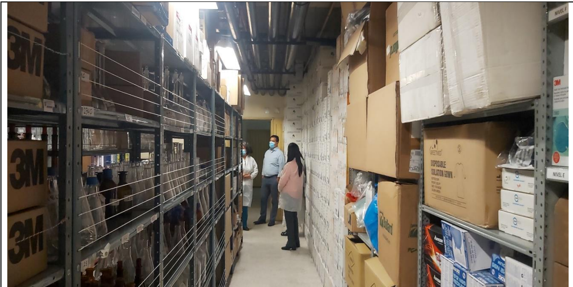
Bodega 1 - Pasillo con elementos de laboratorio; tubería de aguas soportadas en techo.
