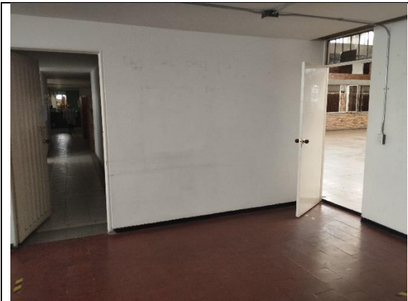
Acceso a bodega de almacenamiento con ruptura de cinta de seguridad.
