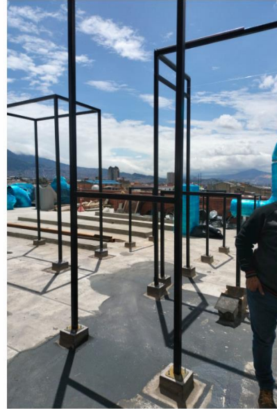
Instalación soportes ductos
