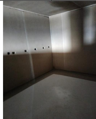
Area interna del Laboratorio (Muros y cielo rasos).
