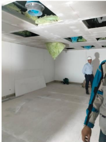
Area interna del laboratorio ( lamina en poliester).
