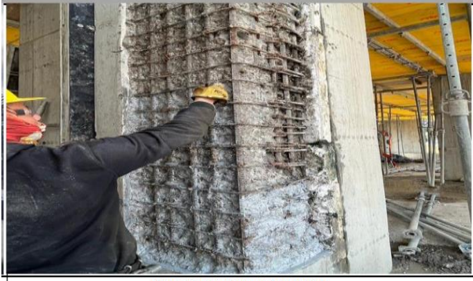
ESCARIFICADO DE COLUMNA, PARA RECALSE
