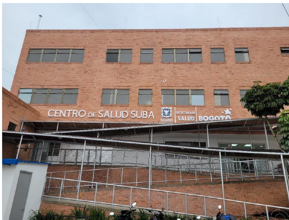
Fuente: Información suministrada por la Dirección de infraestructura- Informe de Interventoría 28 de Febrero de 2023.
