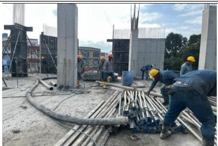
BOMBEO DE CONCRETO
