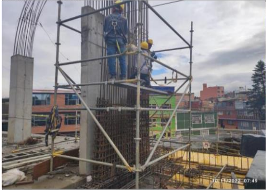
ARMADO DE MUROS PANTALLA
