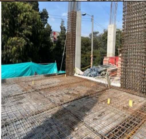
ALISTAMIENTO Y ARMADO PARA FUNDIR PLACA ENTREPISO
