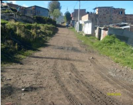
CARRERA 7 ENTRE CALLES 113 SUR Y 114 SUR - ANTES Antes
