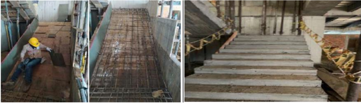
AMARRE DE ACERO ESCALERAS Y FUNDIDA EN CONCRETO SOTANO NIVEL 1
