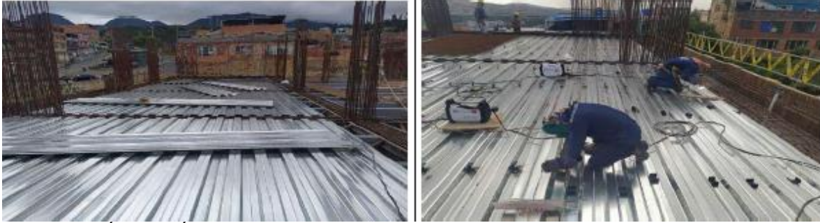
INSTALACIÓN DE LÁMINA CORPALOSA NIVEL 3_ SOLDADURA DE ANCLAJE TIPO C EN PLACA NIVEL 3
