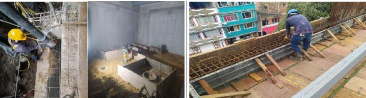
FUNDIDA DE MURO DE CERRAMIENTO
