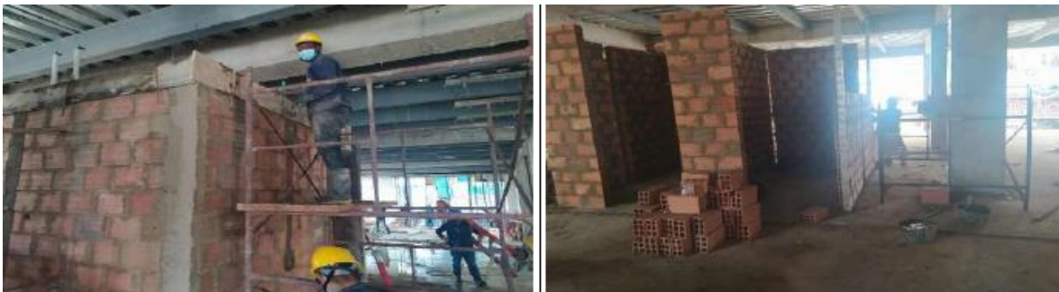
FUNDIDA DE VIGA SUPERIOR EN MAMPOSTERIA NIVEL 1- MUROS EN MAMPOSTERIA
