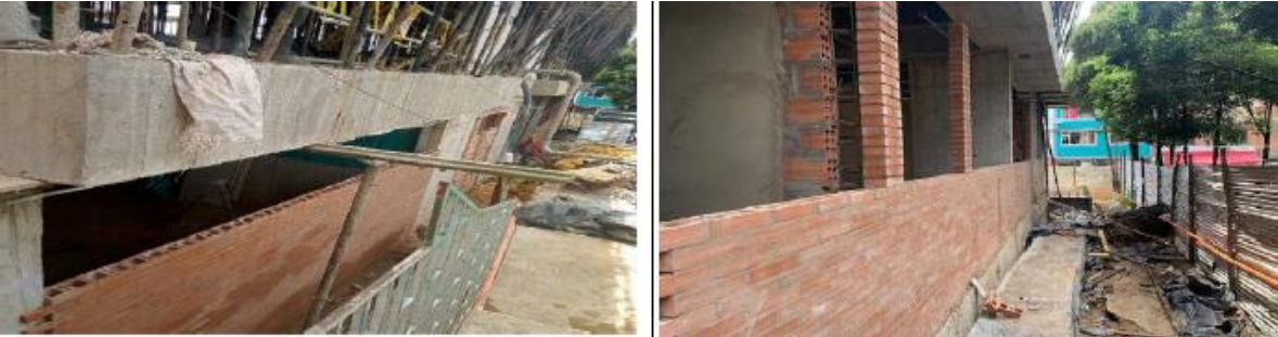
MAMPOSTERIA LADRILLO FACHADA
