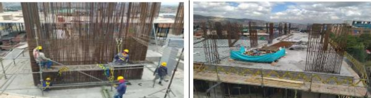
AMARRE DE ACERO PANTALLA ESCALERA NIVEL 2- VISTA DE LA PLACA 3 ENTRE EJES 1 Y 2 G-B
