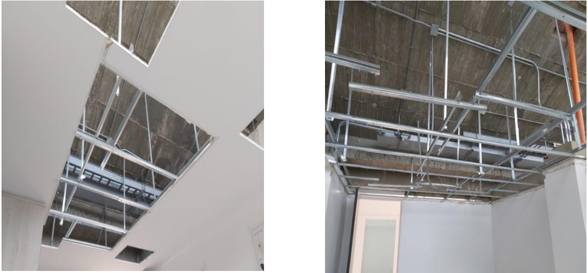
Ilustración 30. Desmonte cielo raso – CAPS Libertadores
