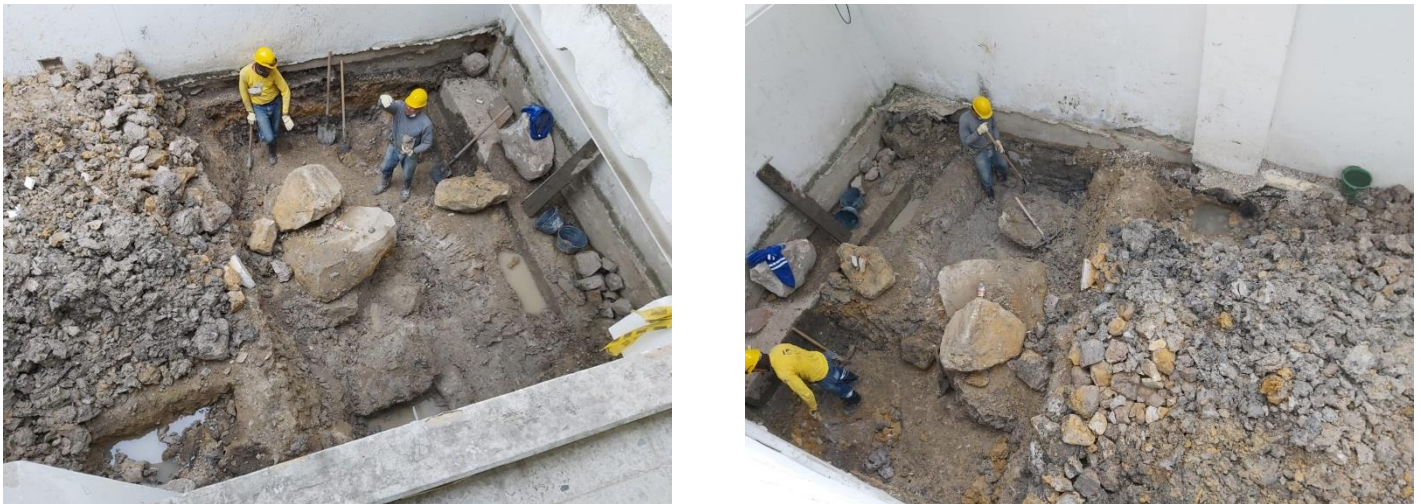
Ilustración 31. Excavación manual tanque contra incendios – CAPS Libertadores
