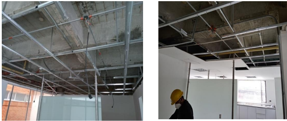
Desmante de cielo raso
